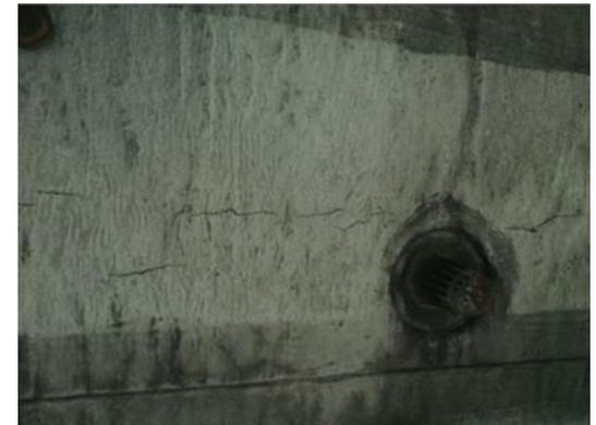
La falta de mantenimiento preventivo ocasiona deterioro prematuro de los sistemas de impermeabilización, estos deben realizarse según el producto a diferentes intervalos de tiempo
