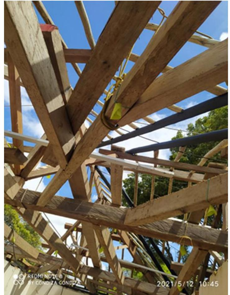
Estructura para cubierta de Teja de barro
