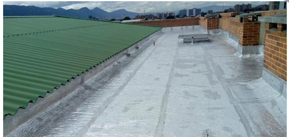
C.R. Almería Real – cubierta en fibrocemento e impermeabilización
