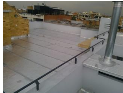
C.R. Almería Real – cubierta en fibrocemento e impermeabilización
