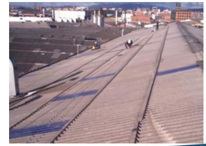
REPARACION CUBIERTA FIBROCEMENTO
