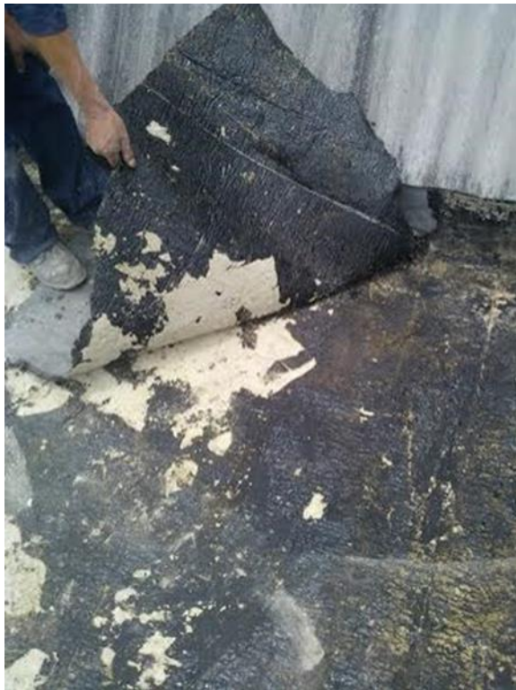
Retiro de manto existente
