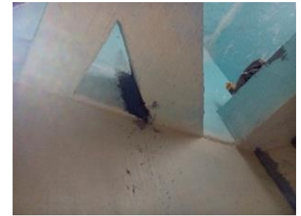
Proceso de aplicación de poliurea
