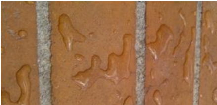
Corrección de fisuras en ladrillo a la vista y en áreas de concreto
